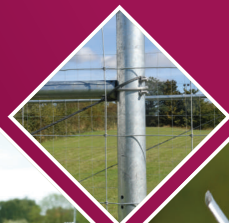
Metallspannsysteme mit horizontalen und diagonalen spannstangen
